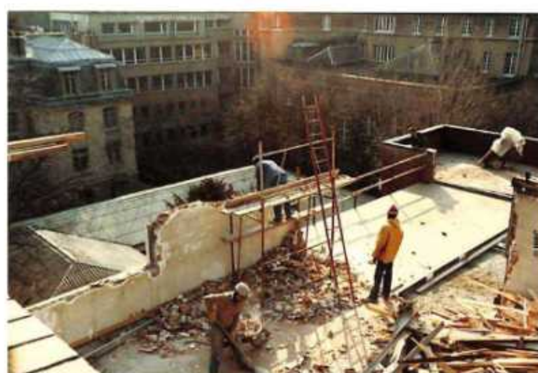
DESTRUCTION DE L'ANCIENNE CAFÉTÉRIA DESTRUCTION OF THE OLD CAFETERIA
