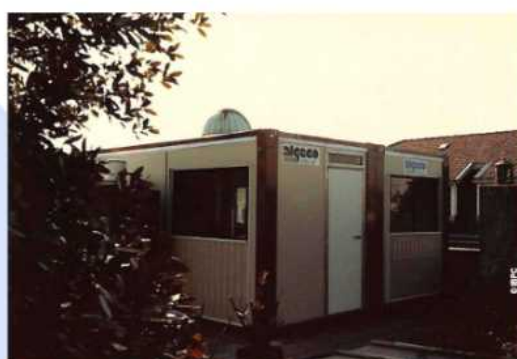
CAFÉTÉRIA TEMPORAIRE SUR LE TOIT DE L'IBPC TEMPORARY CAFETERIA ON THE ROOF OF THE IBPC
